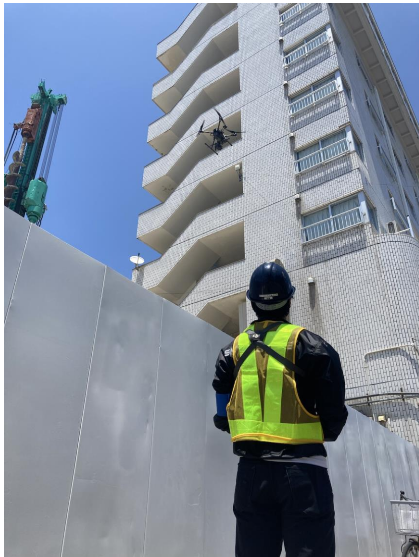
外壁調査の様子
